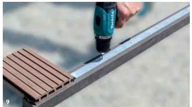
Die Diele einschieben und die freie Seite mit den Montageclips aus Kunststoff und rostfreien Schrauben (3 mm vorbohren) auf der Unterkonstruktion befestigen.
